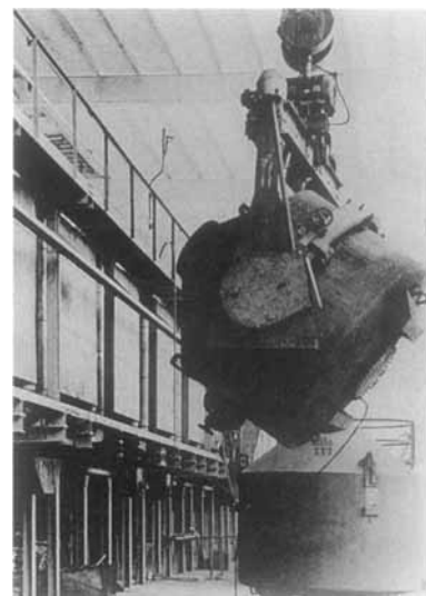
Abb. 6. FT-Normaldruckreaktoren der RCH-Anlage (links) mit Katalysatorein-füllbehälter (1942).
